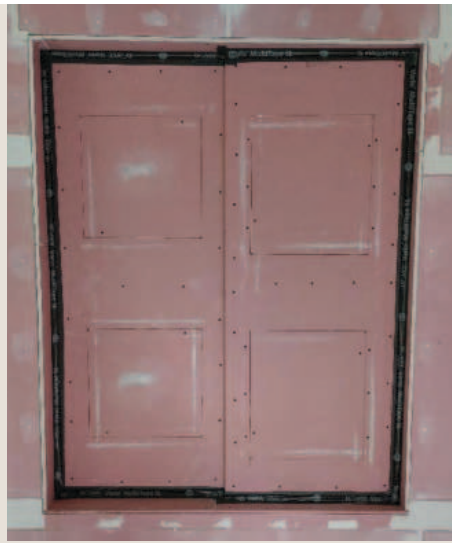
Výskumné otvory vyplnené fragmentmi konštrukcií obvodových stien od firiem NESbau s.r.o. a Mirano s.r.o. (foto: P. Štompf)
